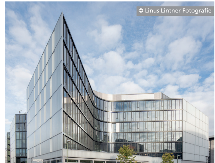
Zalando Headquarter Berlin (Bauteil A und B)
